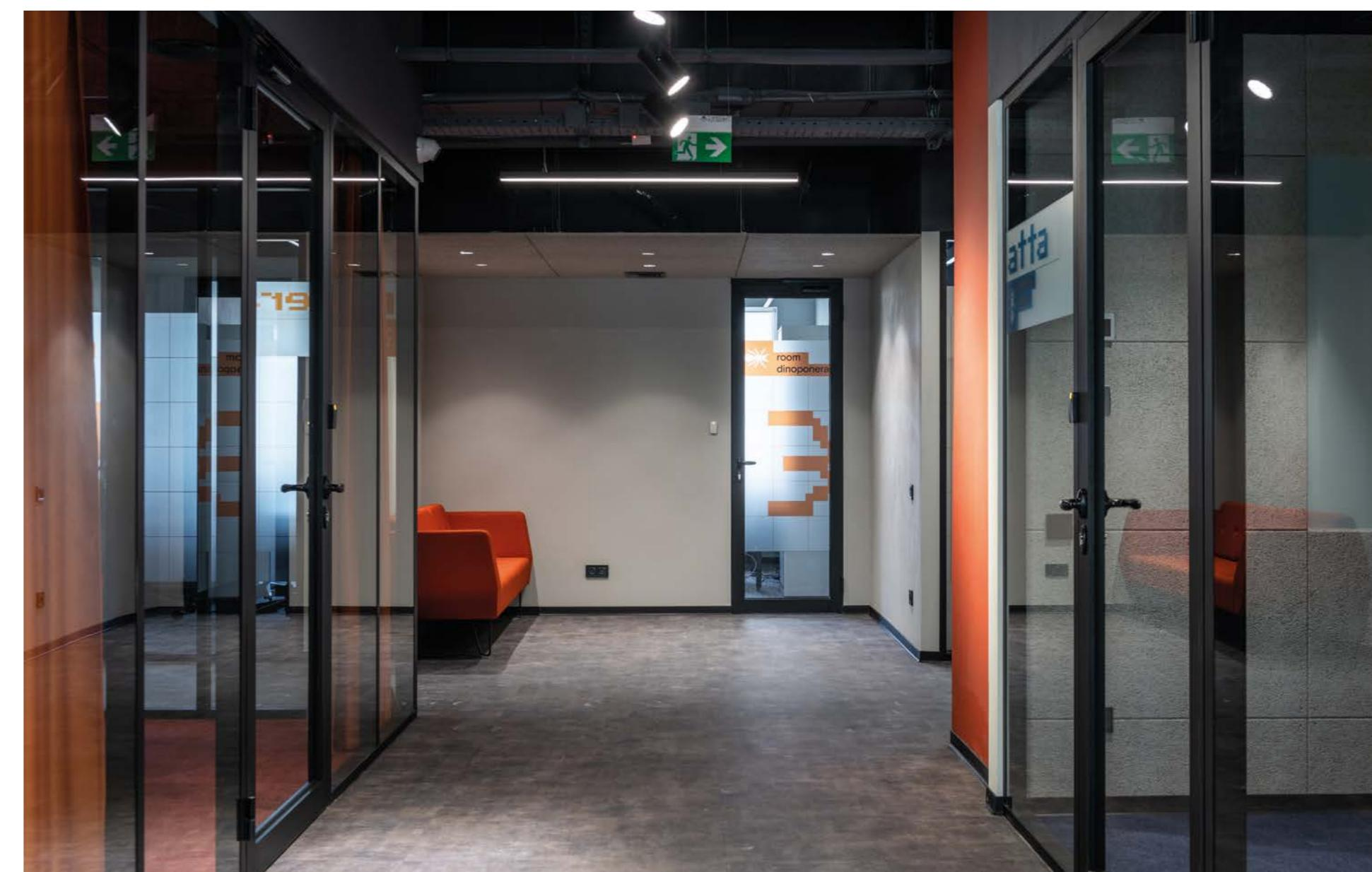
La profundidad constructiva de los paneles de puerta es de 45 mm. Las profundidades de las secciones de hoja y marco adoptadas de esta manera dan el efecto de un plano. La forma de los perfiles permite obtener estructuras de puertas esbeltas y duraderas.
